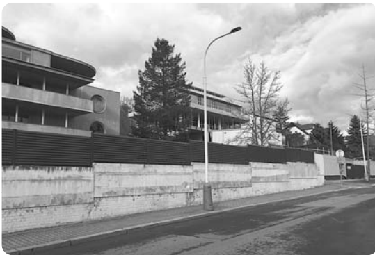
Převýšené plné oplocení u nedokončené novostavby na místě historické usedlosti č. p. 71 – U Lisu
